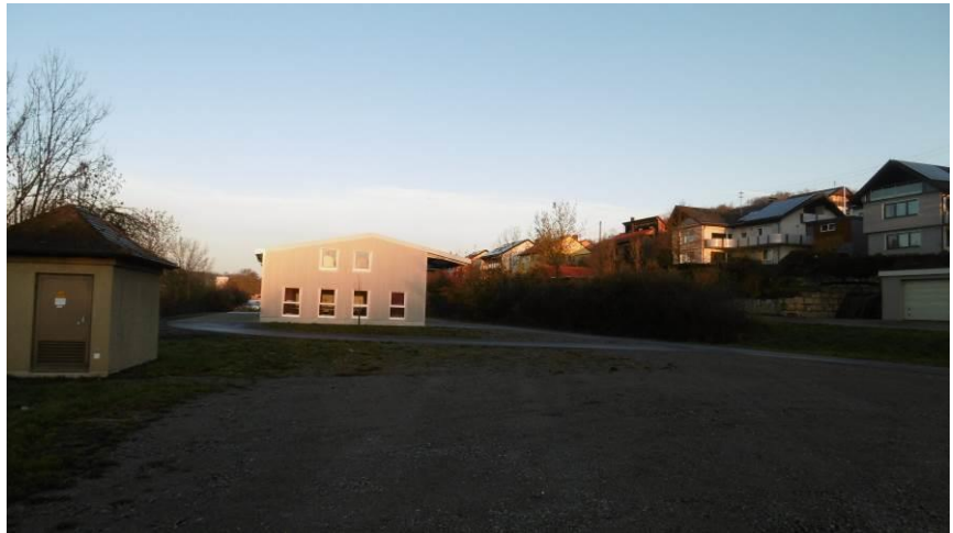
Neuer Bauhof, Bahnhofstraße
