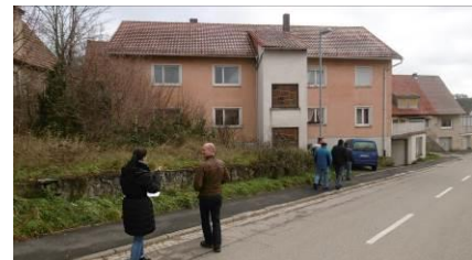
Derzeitige Umnutzung Bahnhofstraße 8
