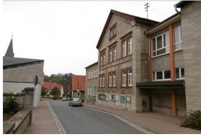
Rathaus und VG-Gebäude
