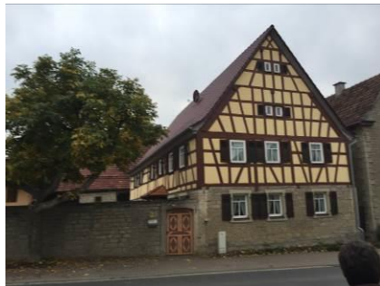
Vorbildlich saniertes Anwesen Hauptstraße 8
